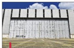
Le hangar Mercure. / PHOTO F.B.
